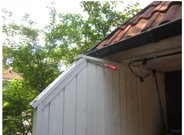
Rötskador vindskydd
