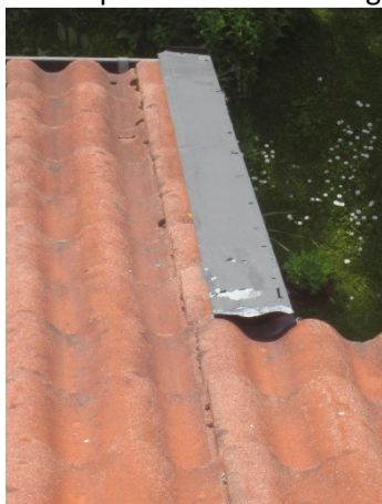
Plåtdetaljer delvis bristfälliga
