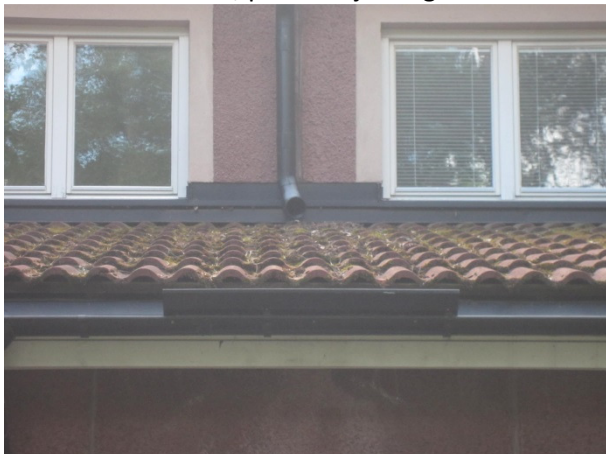
Vatten från stuprör flödar över hängränna....
